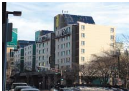
图6 城堡广场公寓节能健康住房改造。照片可见墙窗保暖加固和太阳能光伏电池板。（资料来源：作者）
